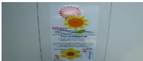
光媒性作用パネルでの仮囲い
