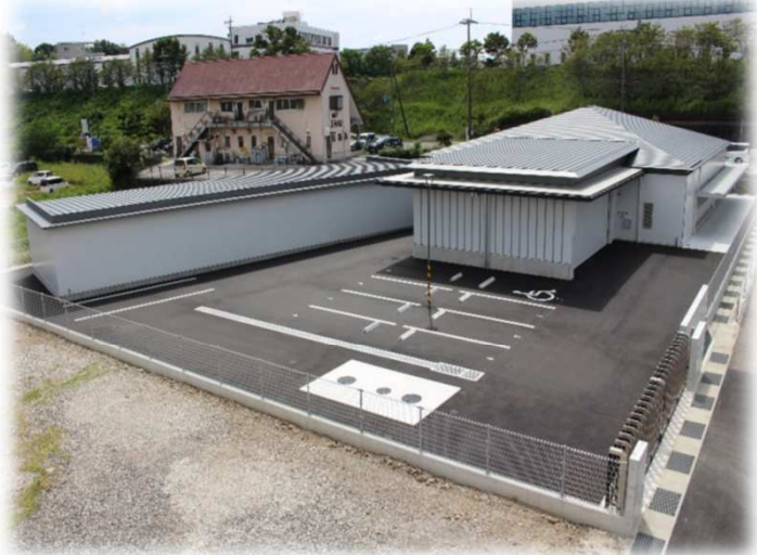
高知銀行南国事務センター新築工事 設計監理：(有)艸建築工房 施工：(株)三宝工務店
